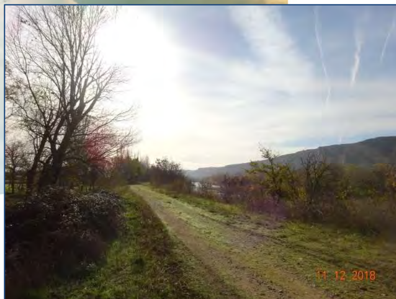
Ilustración 41. Mota sobre el río Arga, aguas abajo del puente de la carretera NA-6120, en la margen izquierda del río. Según señalan responsables municipales, esta es una de las zonas más bajas de la mota, por lo que es en esta parte por la que se producen los primeros desbordamientos en las proximidades del casco urbano de Falces.
