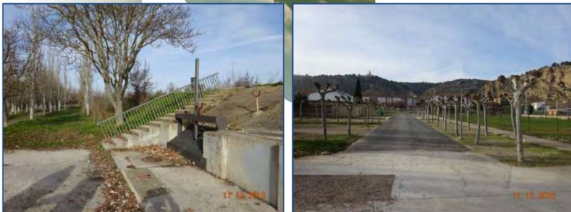
Ilustración 35. Vista de las compuertas (3 compuertas) que regulan la salida del barranco de El Pílon al río Arga, en la zona más baja de la calle San Andrés.
