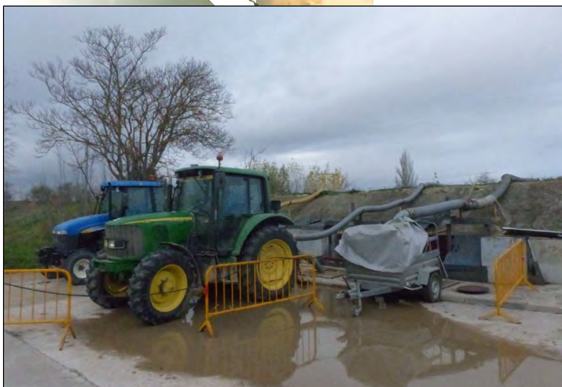
*Imágenes de los trabajos de refuerzo y bombeo efectuados en la mota de Falces durante la inundación de diciembre de 2021.
