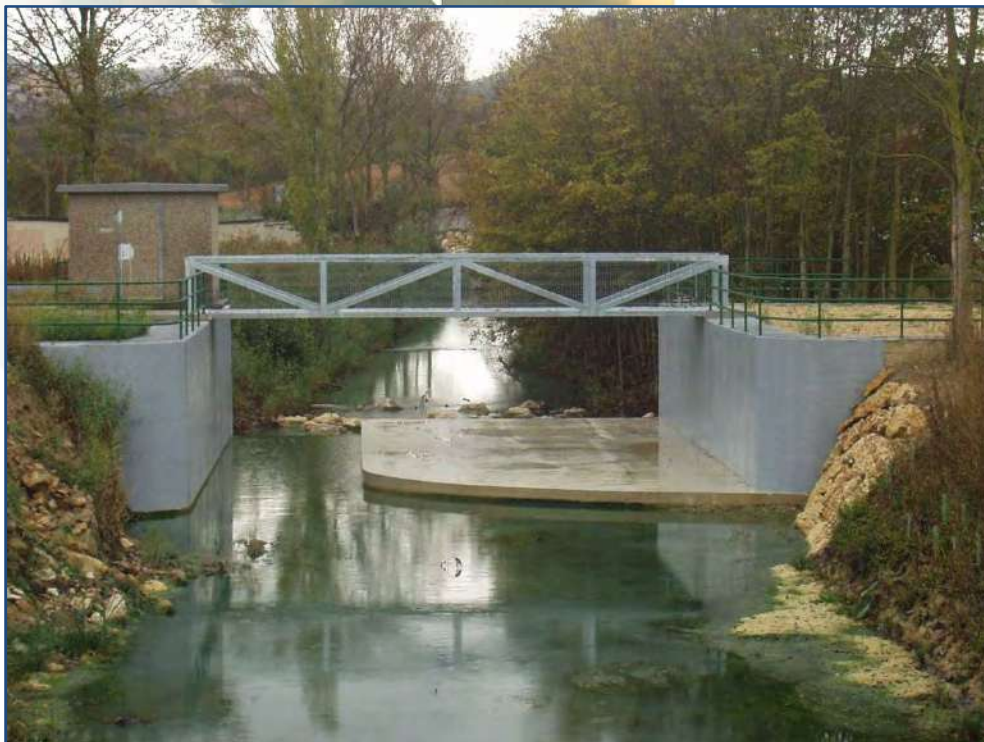
Ilustración 14. Esquema y vista de la estación de aforo de la CHE en el río Salado, en Alloz, aguas abajo del embalse (A084).
