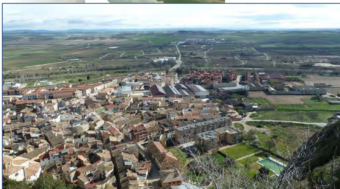
Ilustración 5. Vista del casco urbano, de la localización del puente principal de la localidad, y de la zona industrial al fondo de la imagen.
