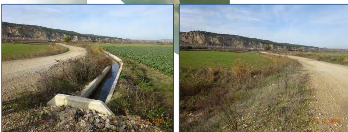
Ilustración 38. Acequias, recientemente mejoradas, en la zona de regadío de la margen izquierda del río. Algunos de los caminos también han sido sobre elevados fruto de las obras llevadas a cabo en el regadío.
