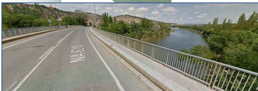
Ilustración 12. Puente de la carretera 6210 sobre el río Arga en Falces.
