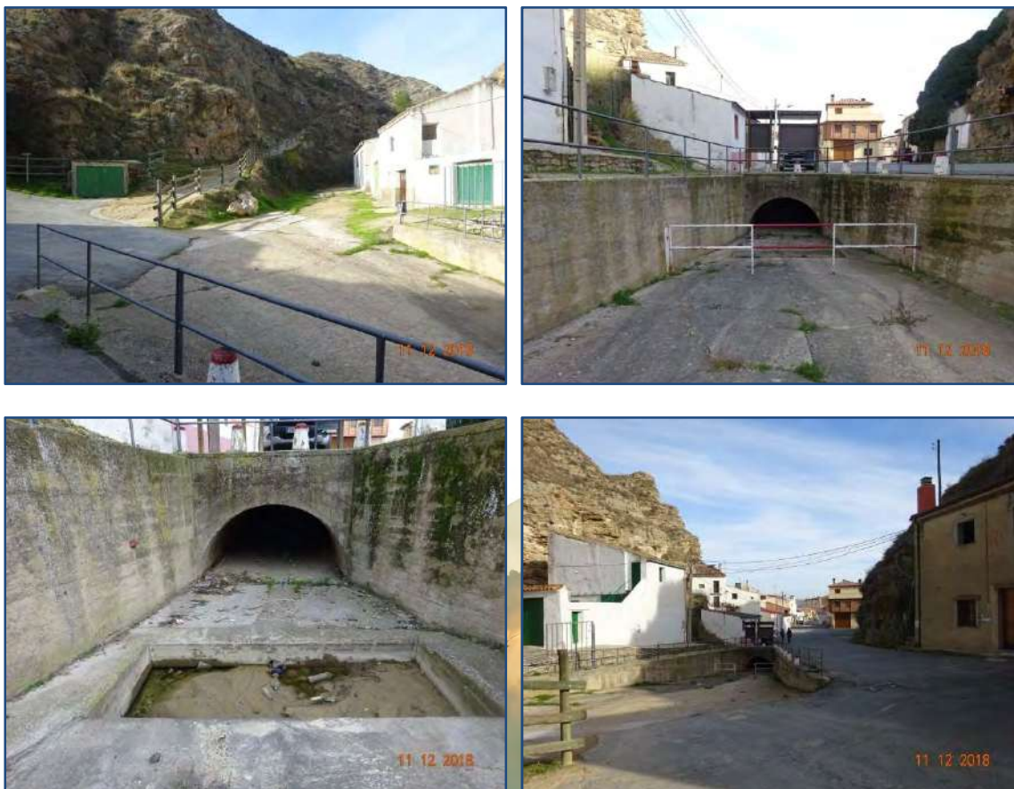
Ilustración 42. Fotos de la zona de soterramiento del barranco de El Pilón. En la imagen superior izquierda se ilustra la zona más baja de la cuenca que vierte al barranco. En la inferior izquierda puede observarse el depósito que se construyó para intentar retener principalmente sedimentos, o cualquier otro tipo de basura proveniente del barranco. De esta forma se pretende evitar la entrada de materiales en el barranco soterrado, que puedan dar lugar a peligrosos taponamientos del mismo. En la imagen inferior derecha se muestra la zona, ya urbana, por la que se inician los desbordamientos en casos de tormentas importantes con volúmenes superiores a los que pueden circular por el cauce soterrado.
